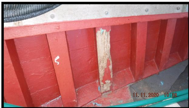
La falchetta, protetta da profilato in acciaio, è appoggiata a scalmotti, con evidenza di carente manutenzione.
