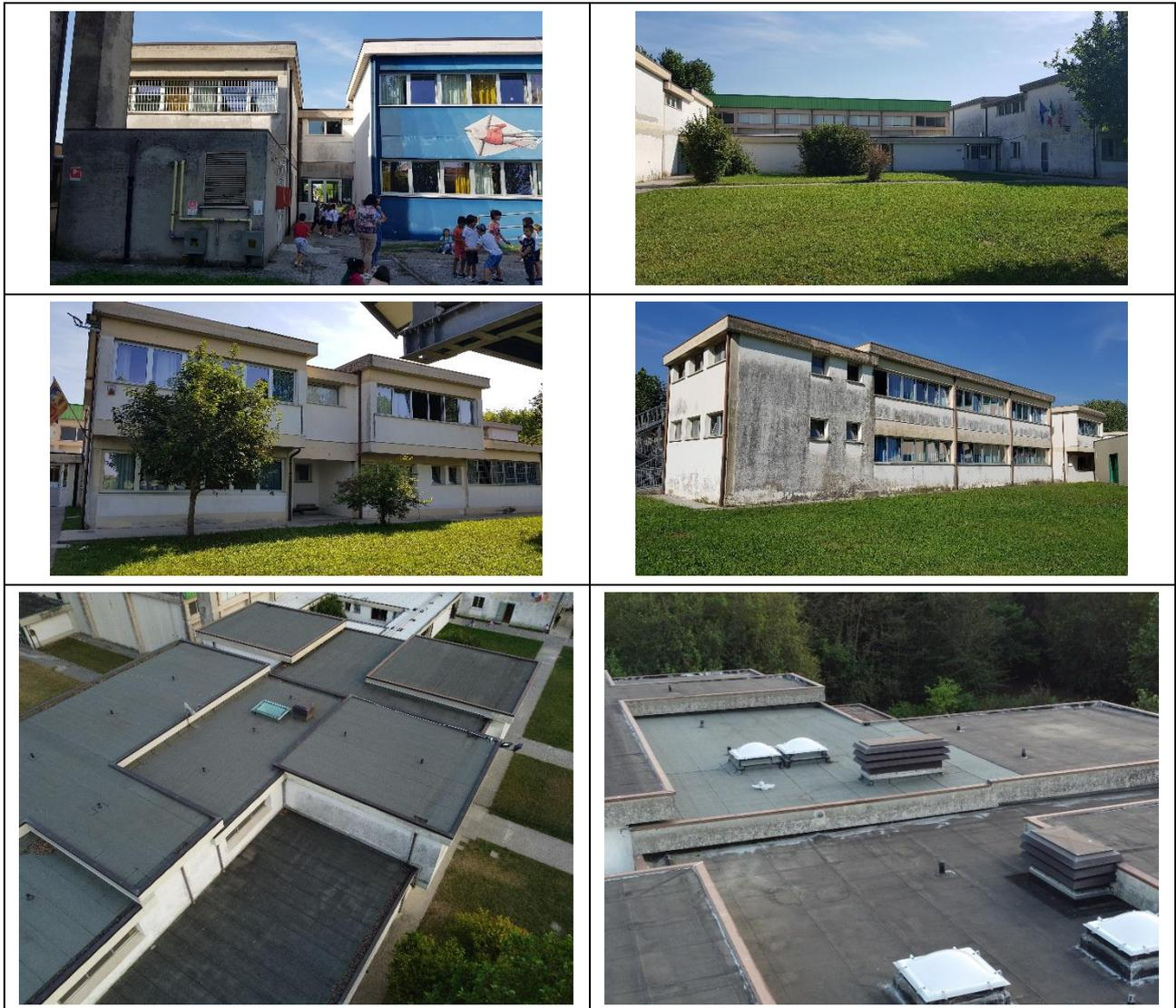
L'oggetto dei lavori riguarda l'efficientamento energetico tramite la realizzazione del sistema a cappotto delle strutture opache tramite la posa di isolante e la coibentazione e impermeabilizzazione della copertura tramite la posa di pannelli isolanti in PIR e realizzazione di una copertura ventilata. A completamento verranno sostituiti i canali di gronda e i pluviali ad oggi in stato di degrado.
