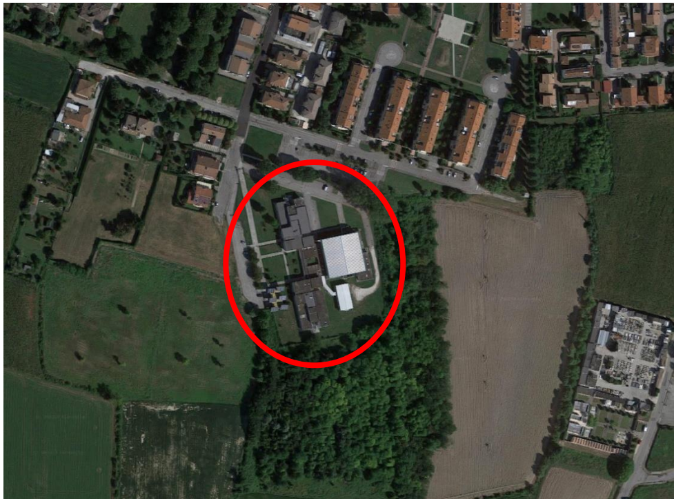
Figura 1 – Inquadramento su ortofoto dell'edificio oggetto di intervento
