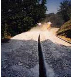
Trattasi della scarificazione, taglio e rottura di massicciata stradale consolidata con mezzi meccanici (fresatrice, martello demolitore o simile) ed attrezzi manuali di uso comune..
