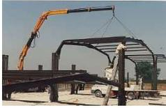
La attività consiste nella movimentazione dei carichi in cantiere eseguita mediante autogru di portata e caratteristiche idonee agli elementi da movimentare. Oltre alle istruzioni riportate nella presente scheda, i lavoratori addetti dovranno attenersi alle istruzioni riportate nella scheda specifica dell'autogru.
