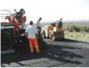
La fase di lavoro prevede la finitura del manto stradale formato da: conglomerato bituminoso (binder) e tappetino, stesi a caldo e di vario spessore. I vari strati sono stesi con vibrofinitrice, previo spandimento di bitume liquido su sottofondo già predisposto.
