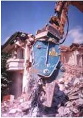
Trattasi delle operazioni di demolizione di fabbricati in genere eseguite fino al piano di spiccato con mezzi meccanici attrezzati allo scopo o a mano dove occorra.
