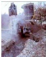
Per scavi a sezione ristretta (o in trincea) si intendono quelli continui (correnti) di sezione trasversale ristretta per i quali, non essendo consentito ai mezzi di trasporto per il carico dei materiali l'accesso frontale al fondo del cavo, si rendono necessari due paleggiamenti come per lo scavo a sezione obbligata. Generalmente, questi tipi di scavo vengono utilizzati per la posa di tubazioni, sottoservizi, ecc...
