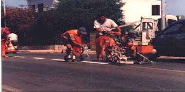
Trattasi della verniciatura della segnaletica orizzontale stradale eseguita mediante compressore a spruzzo manuale o su automezzo speciale.
