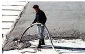
Trattasi delle operazioni di sollevamento e getto di calcestruzzo mediante pompa ed autobetoniera.
