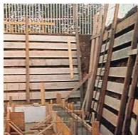
Trattasi di armatura provvisoria costituita da montanti e puntoni metallici o di legno, atta a sostenere le pareti di uno scavo. Infatti, quando la parete del fronte dello scavo supera l'altezza di mt 1,50 e la consistenza del terreno non da sufficiente garanzia di stabilità, anche in relazione alla pendenza delle pareti, è obbligatorio l'applicazione dell'armatura di sostegno, sporgente almeno 30 cm dal ciglio ed estesa fino al fondo dello scavo.
