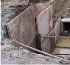
Quando la collocazione dello scavo o la sua profondità non consentono di realizzare le pareti secondo l'angolo d'attrito interno del terreno, o si supera l'altezza critica caratteristica del materiale, è necessario armare lo scavo.
