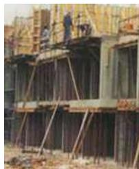
Trattasi dello smontaggio delle casseforme di strutture in c.a., ossia dei vari elementi piani o curvi, dei dispositivi per l'assemblaggio e degli elementi di sostegno, detti banchinaggio. In generale, il disarmo delle strutture in c.a. avviene secondo le seguenti modalità:
