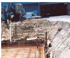
Per scavi di fondazione in genere si intendono quelli incassati ed a sezione ristretta necessari per dar luogo ai muri, ed ai plinti di fondazione propriamente detti. In ogni caso saranno considerati come scavi di fondazione quelli per dar luogo alle fogne, condutture, fossi e cunette. Qualunque sia la natura e la qualità del terreno, gli scavi di fondazione, dovranno essere spinti fino alla profondità che dalla Direzione Lavori verrà ordinata all'atto della loro esecuzione.
